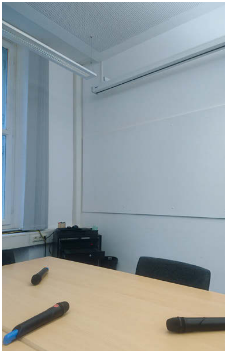
Der Besprechungsraum 0.31 in der Burgstraße 4 wurde mit einer fest installierten Induktionsschleife ertüchtigt und mit einer Deckendämmung zur Verbesserung der Raumakustik ausgestattet.
